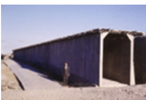
Id: I/FC-129/011 Título: Detalle del puente en onstrucción e imagen de Carlos Fernández Casado
