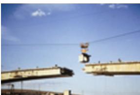
Id: I/FC-129/010 Título: Detalle del puente en construcción
