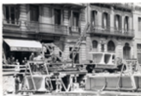
Id: I/FC-117/012 Título: Detalle de las obras Dimensiones: 69 x 115 mm
