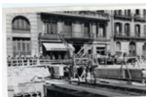
Id: I/FC-117/011 Título: Detalle de las obras Dimensiones: 71 x 115 mm
