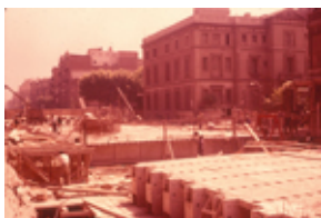
Id: I/FC-117/015 Título: Vista de las obras Dimensiones: 24 x 33 mm
