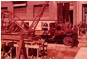
Id: I/FC-117/024 Título: Detalle de las obras Dimensiones: 23 x 33 mm
