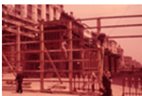
Id: I/FC-117/016 Título: Detalle de las obras Dimensiones: 23 x 33 mm
