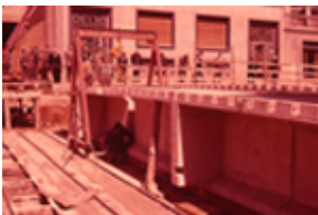
Id: I/FC-117/032 Título: Detalle de las obras Dimensiones: 23 x 35 mm
