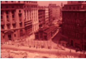
Id: I/FC-117/018 Título: Vista de las obras Dimensiones: 23 x 35 mm
