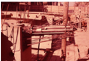
Id: I/FC-117/027 Título: Detalle de las obras Dimensiones: 23 x 33 mm
