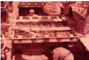
Id: I/FC-117/031 Título: Detalle de las obras, obreros trabajando Dimensiones: 23 x 33 mm
