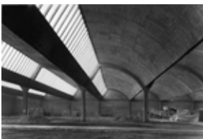
Id: I/FC-096/047 Título: Vista del interior de la escuela en construcción
