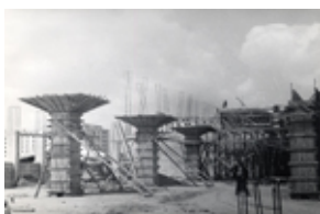
Id: I/FC-088/007 Título: Vista de la estación en construcción Dimensiones: 181 x 239 mm
