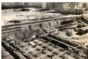
Id: I/FC-088/010 Título: Vista aérea de la estación en construcción Dimensiones: 176 x 240 mm
