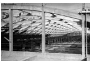
Id: I/FC-088/011 Título: Detalle de construcción de la estación Dimensiones: 115 x 174 mm
