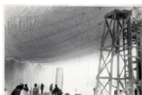
Id: I/FC-076/011 Título: Vista interior de la cubierta, obreros trabajando Dimensiones: 129 x 179 mm
