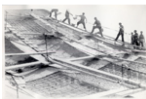
Id: I/FC-076/010 Título: Vista obreros trabajando en la cubierta Dimensiones: 130 x 179 mm
