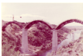
Id: I/FC-052/010 Título: Construcción de los forjados de los arcos Dimensiones: 77 x 114 mm
