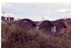
Id: I/FC-052/011 Título: Construcción de los forjados de los arcos Dimensiones: 88 x 126 mm
