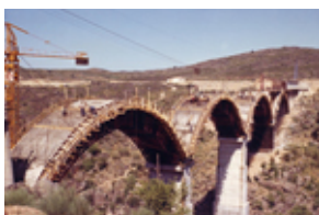
Id: I/FC-052/008 Título: Construcción de los arcos del puente Dimensiones: 80 x 117 mm
