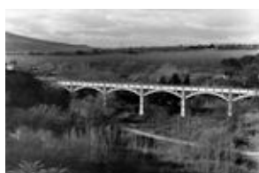
Id: I/FC-052/062 Título: Vista general del puente
