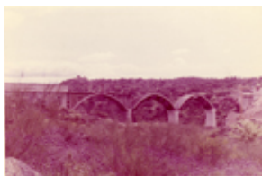
Id: I/FC-052/009 Título: Vista del puente durante su construcción Dimensiones: 79 x 114 mm
