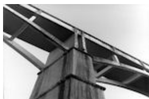
Id: I/FC-052/061 Título: Vista de una de las pilas y de la parte inferior del tablero
