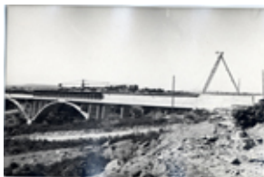
Id: I/FC-052/006 Título: Construcción del tablero Dimensiones: 74 x 103 mm
