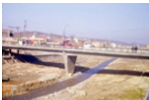
Id: I/FC-034/011 Título: Vista del puente con gente y vehículos sobre el puente "B" Dimensiones: 23 x 35 mm
