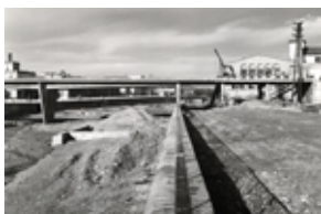
Id: I/FC-034/009 Título: Vista de unos de los laterales del puente "A" Dimensiones: 171 x 230 mm
