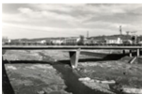
Id: I/FC-034/007 Título: Tramo central del puente "A" Dimensiones: 171 x 210 mm
