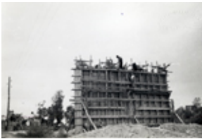
Id: I/FC-009/012 Título: Construcción de una pila Dimensiones: 121 x 168 mm
