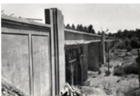
Id: I/FC-009/016 Título: Vista del puente en construcción Dimensiones: 108 x 169 mm
