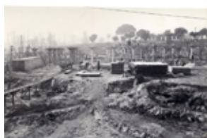
Id: I/FC-003/074 Título: Vista del puente en construcción Dimensiones: 141 x 230 mm
