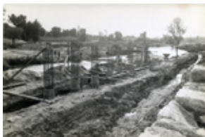
Id: I/FC-003/099 Título: Vista del puente en construcción Dimensiones: 173 x 234 mm
