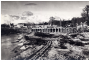
Id: I/FC-003/079 Título: Vista del puente en construcción Dimensiones: 150 x 234 mm
