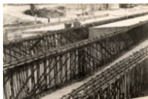
Id: I/FC-003/076 Título: Detalle del puente en construcción Dimensiones: 175 x 233 mm
