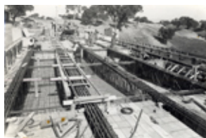
Id: I/FC-003/072 Título: Detalle del puente en construcción Dimensiones: 118 x 171 mm
