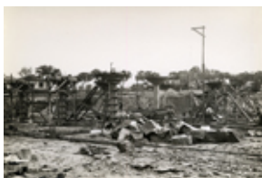
Id: I/FC-003/009 Título: Vista del puente en construcción Dimensiones: 172 x 234 mm
