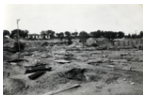
Id: I/FC-003/073 Título: Vista del puente en construcción Dimensiones: 173 x 234 mm
