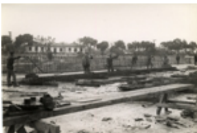
Id: I/FC-003/080 Título: Detalle del puente en construcción Dimensiones: 165 x 235 mm
