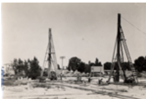
Id: I/FC-003/081 Título: Detalle del puente en construcción Dimensiones: 82 x 113 mm
