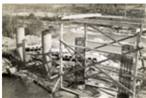
Id: I/FC-003/100 Título: Detalle del puente en construcción Dimensiones: 176 x 236 mm
