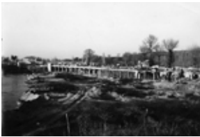
Id: I/FC-003/078 Título: Vista del puente en construcción Dimensiones: 157 x 229 mm
