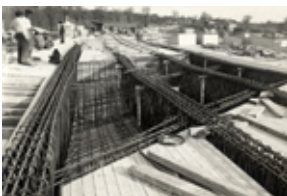
Id: I/FC-003/083 Título: Detalle del puente en construcción Dimensiones: 82 x 113 mm
