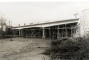
Id: I/FC-003/038 Título: Vista del puente en construcción Dimensiones: 160 x 234 mm
