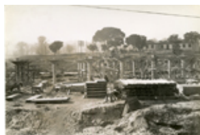
Id: I/FC-003/075 Título: Vista del puente en construcción Dimensiones: 172 x 233 mm
