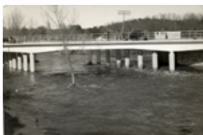
Id: I/FC-003/093 Título: Vista del puente en construcción Dimensiones: 170 x 234 mm
