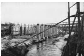
Id: I/FC-003/115 Título: Vista del puente en construcción Dimensiones: 162 x 230 mm
