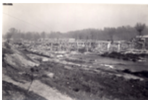
Id: I/FC-003/011 Título: Vista del puente en construcción Dimensiones: 154 x 233 mm
