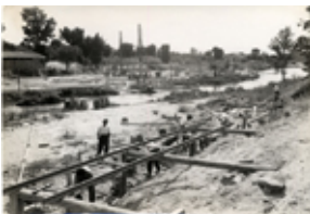
Id: I/FC-003/040 Título: Detalle del puente en construcción Dimensiones: 174 x 235 mm
