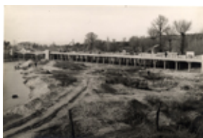
Id: I/FC-003/010 Título: Vista del puente en construcción Dimensiones: 158 x 234 mm
