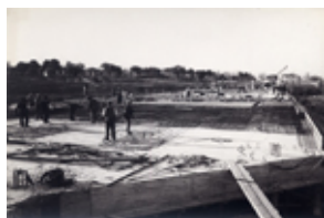
Id: I/FC-003/042 Título: Detalle del puente en construcción Dimensiones: 167 x 228 mm
