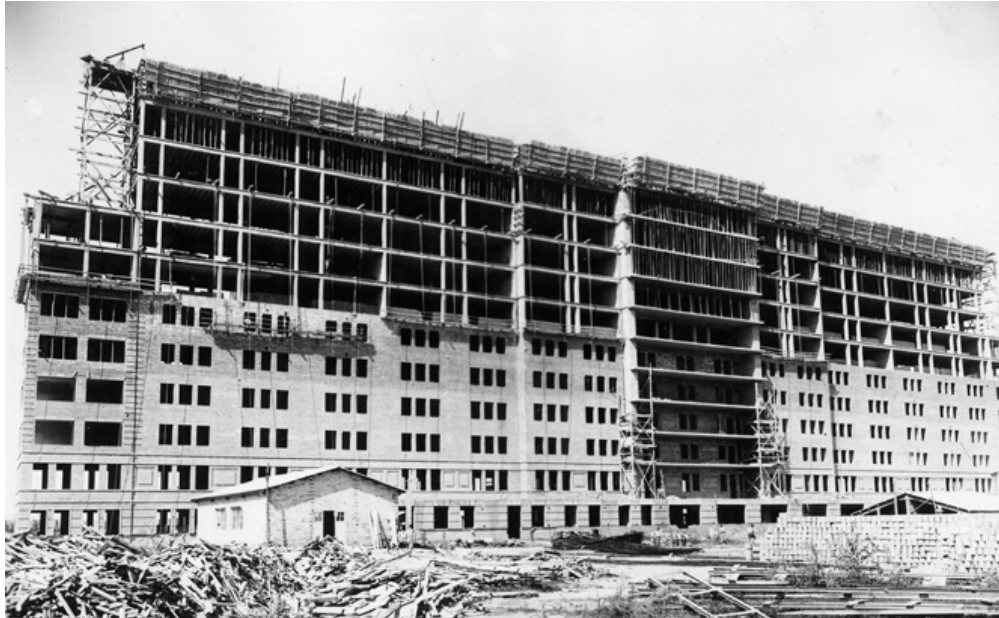
Vista de la residencia en construcción
