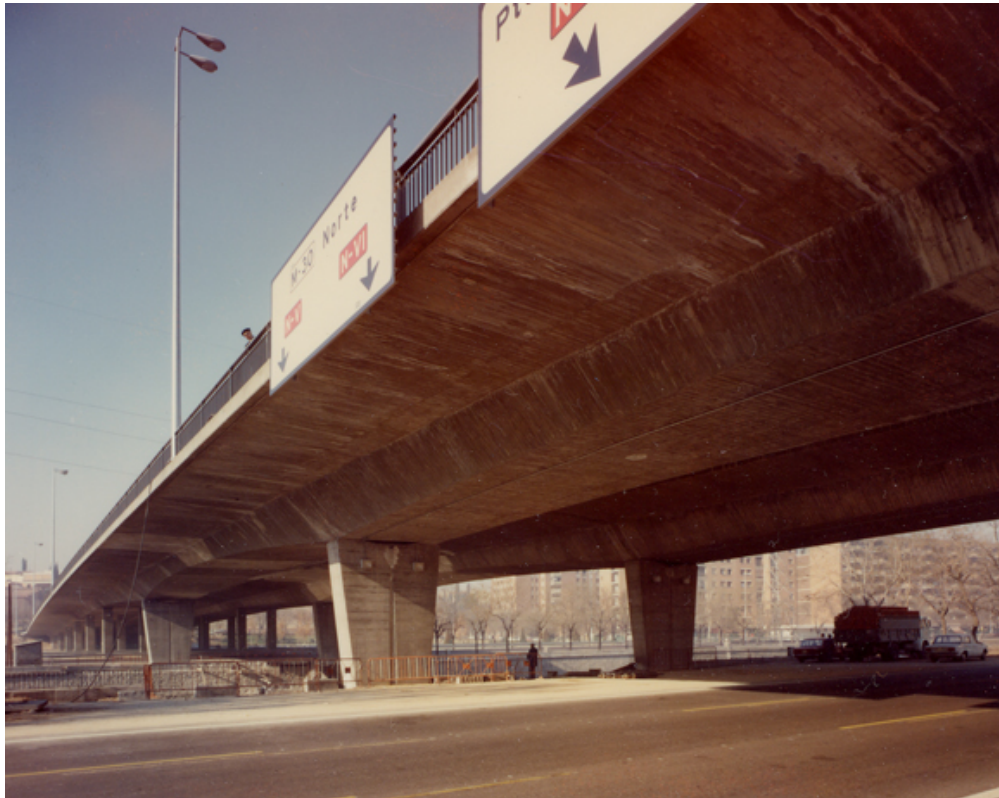
Detalle del puente
