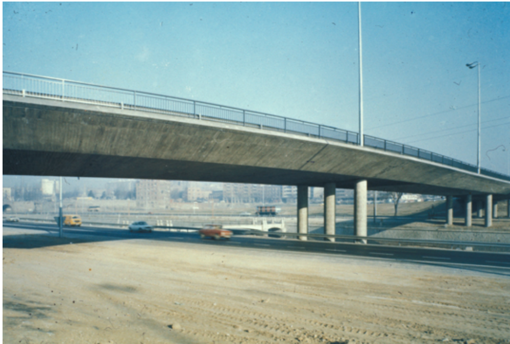
Detalle del puente
