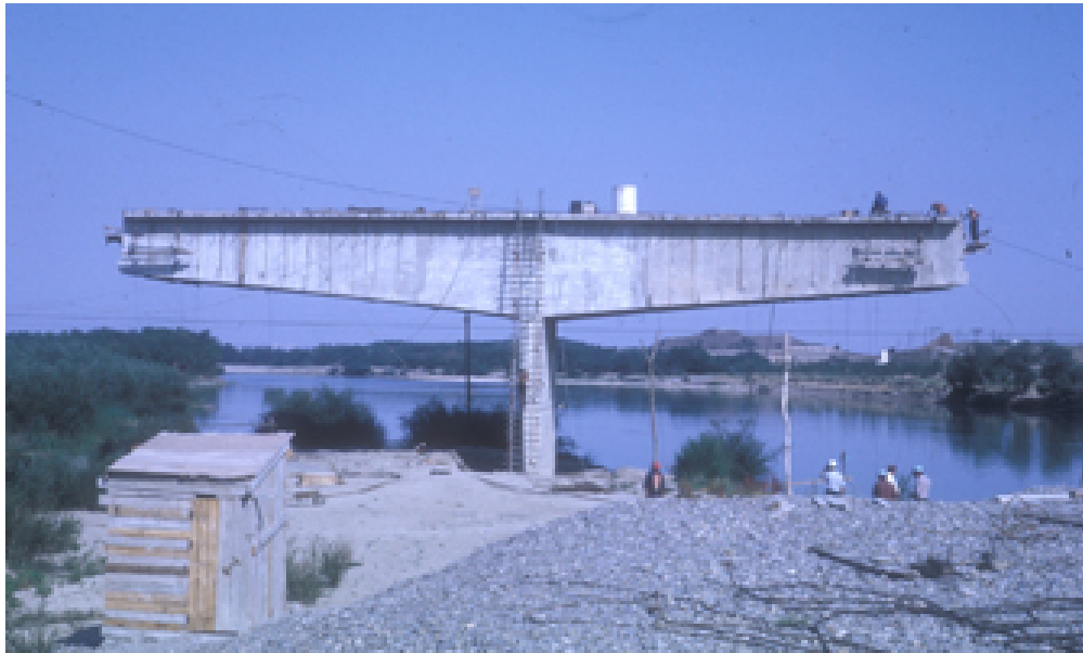
Detalle del puente en construcción
