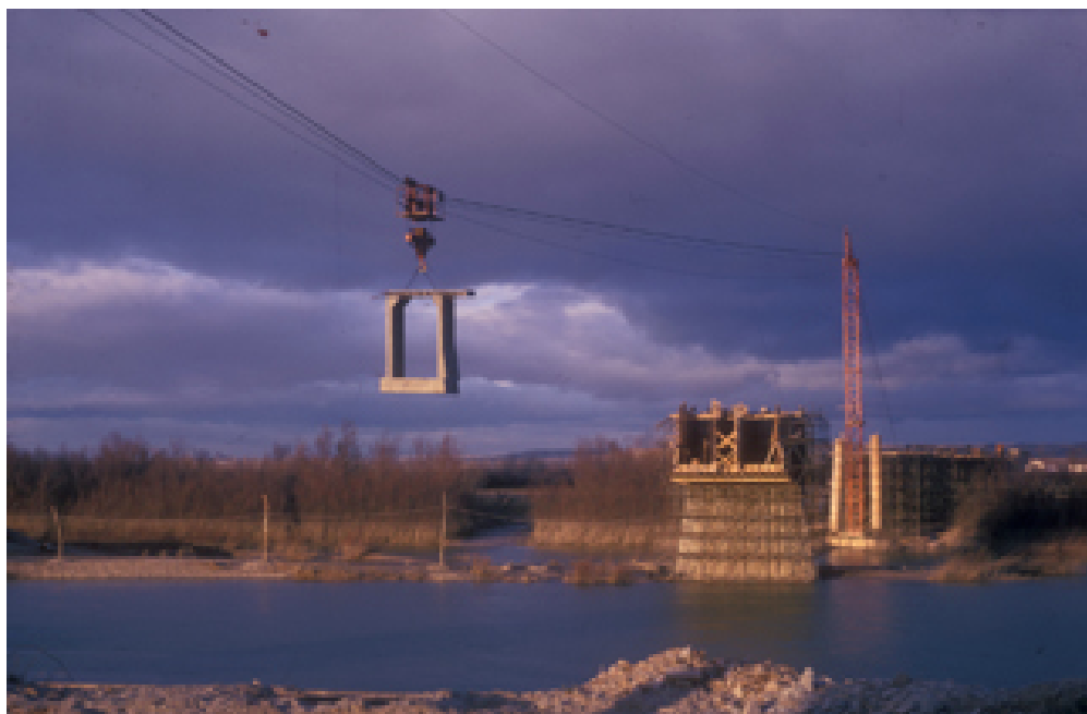
Detalle del puente en construcción
