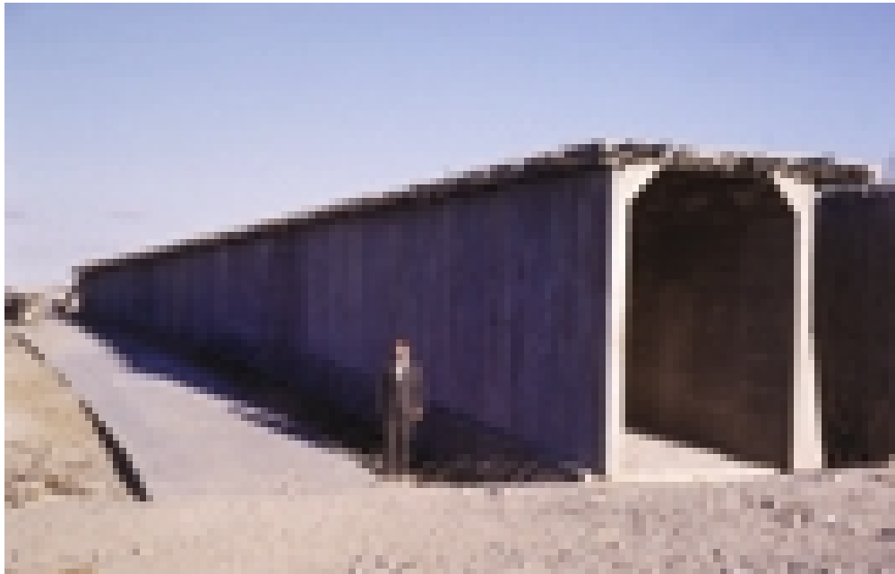
Detalle del puente en onstrucción e imagen de Carlos Fernández Casado
