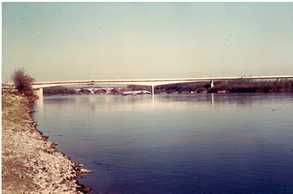
Vista del puente
