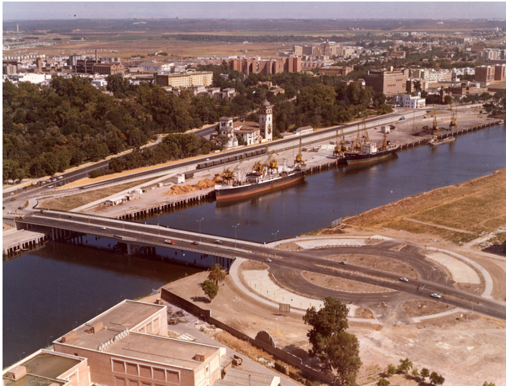
Vista panorámica del puente
