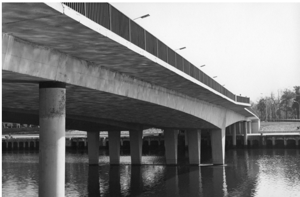
Detalle del puente
