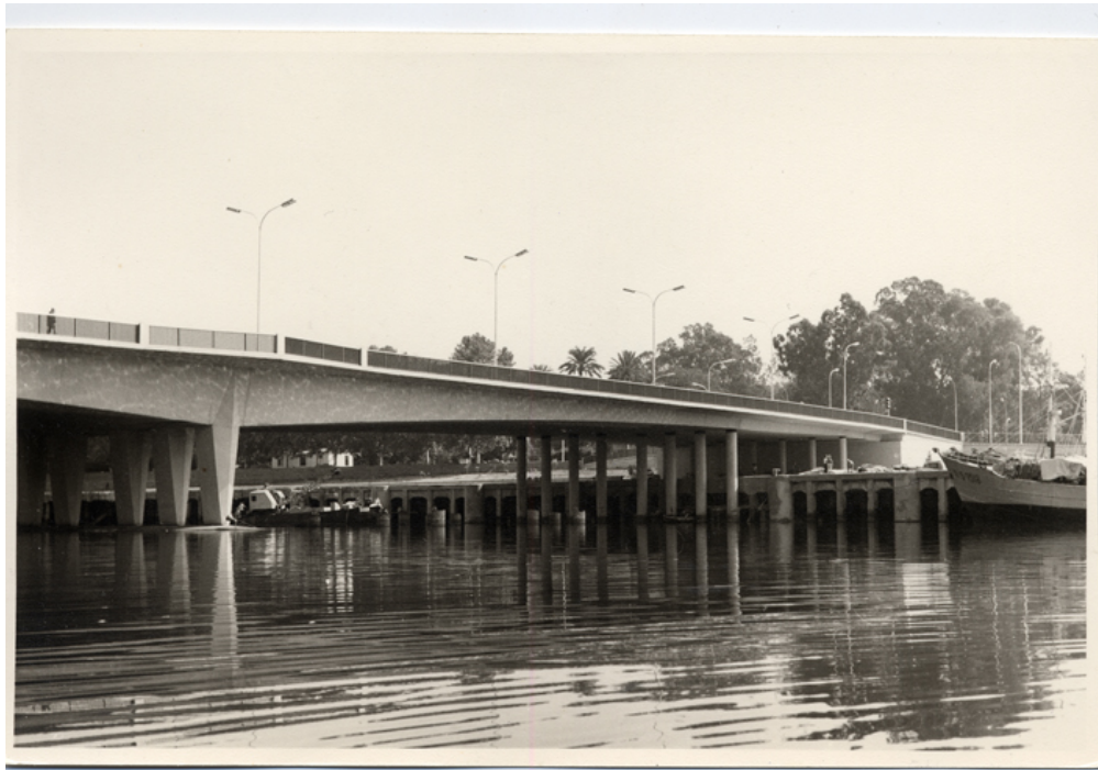
Vista del puente
