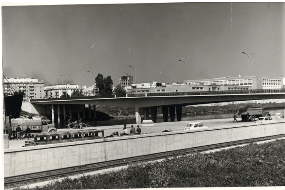
Vista del puente
