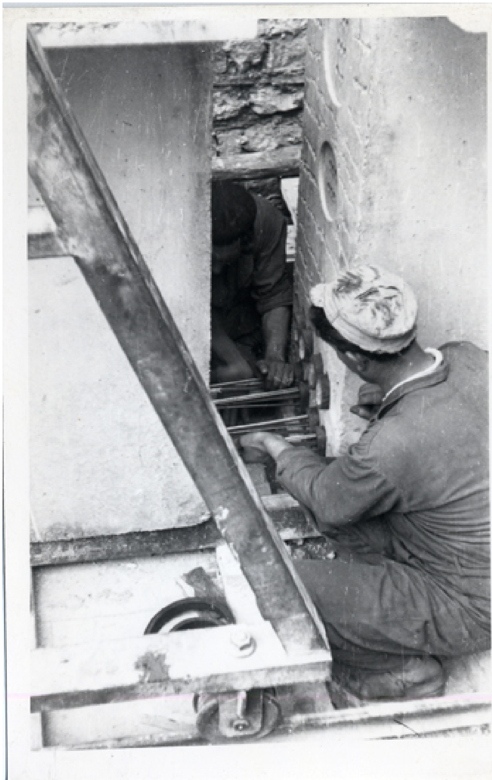
Detalle de construcción, obreros trabajando
