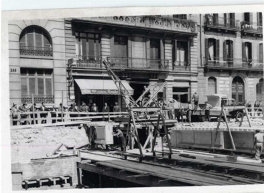
Detalle de las obras
