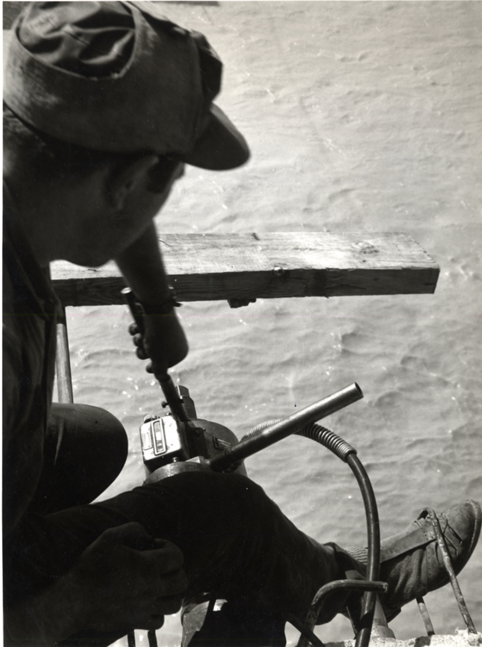
Detalle obrero manipulando maquinaria
