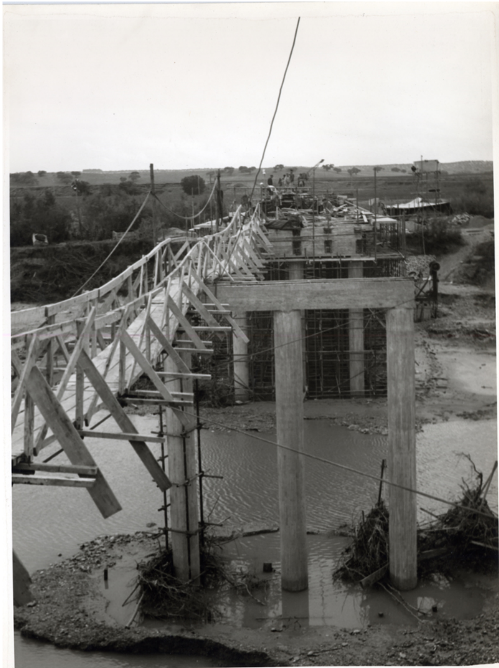
Vista del puente en construcción
