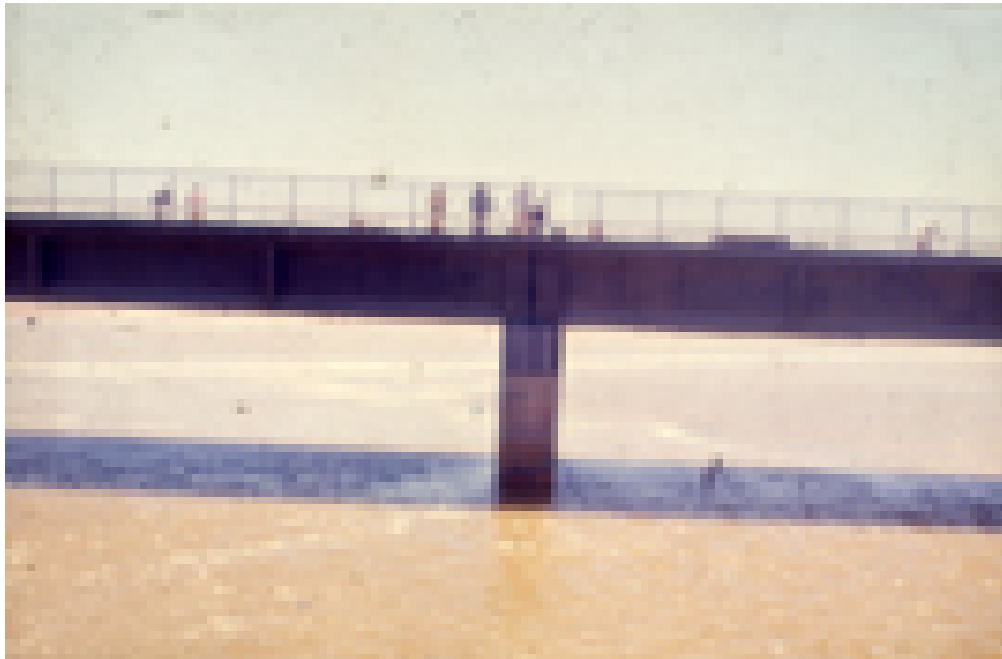
Vista del puente
