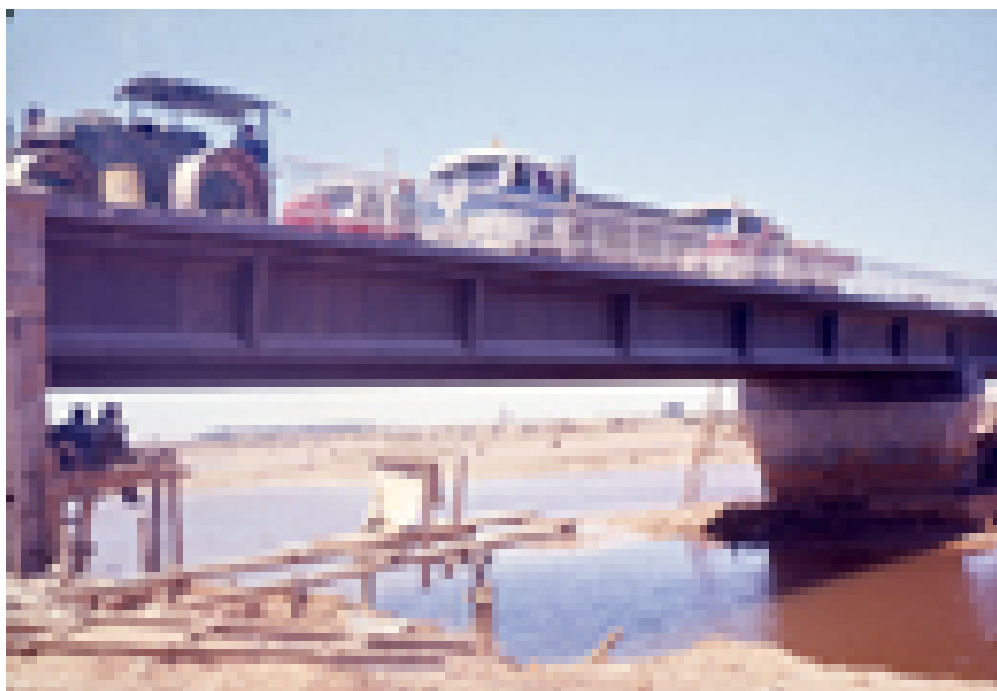
Vista paso de camiones y maquinaria sobre el puente en construcción
