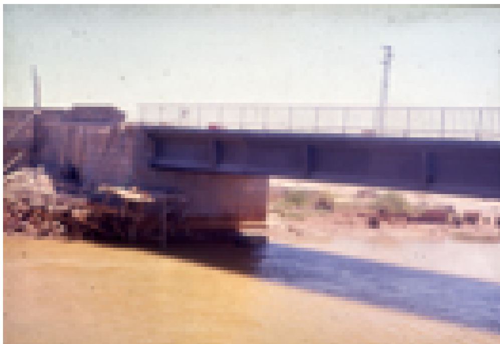
Vista del puente
