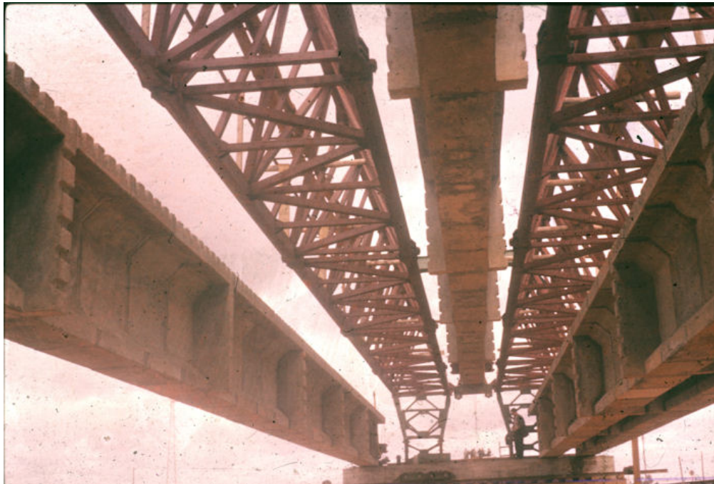
Detalle del puente
