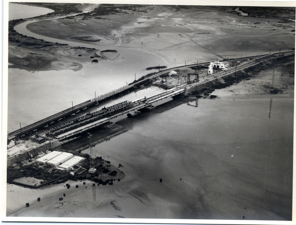
Vista aérea del puente
