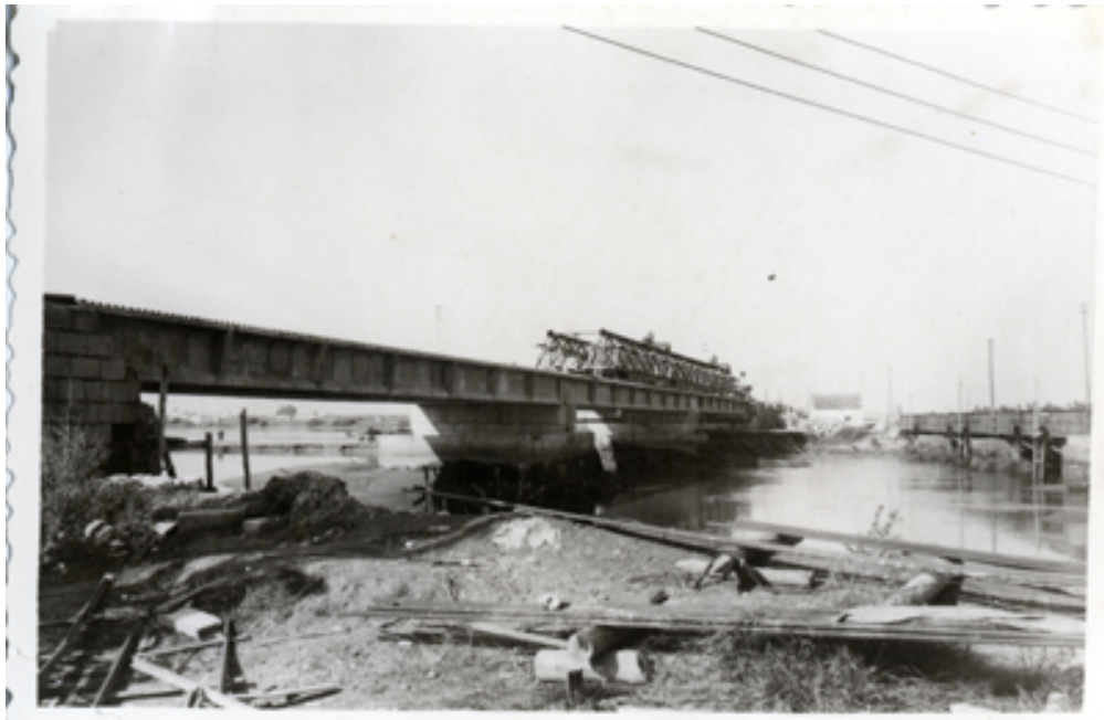
Vista del puente en construcción
