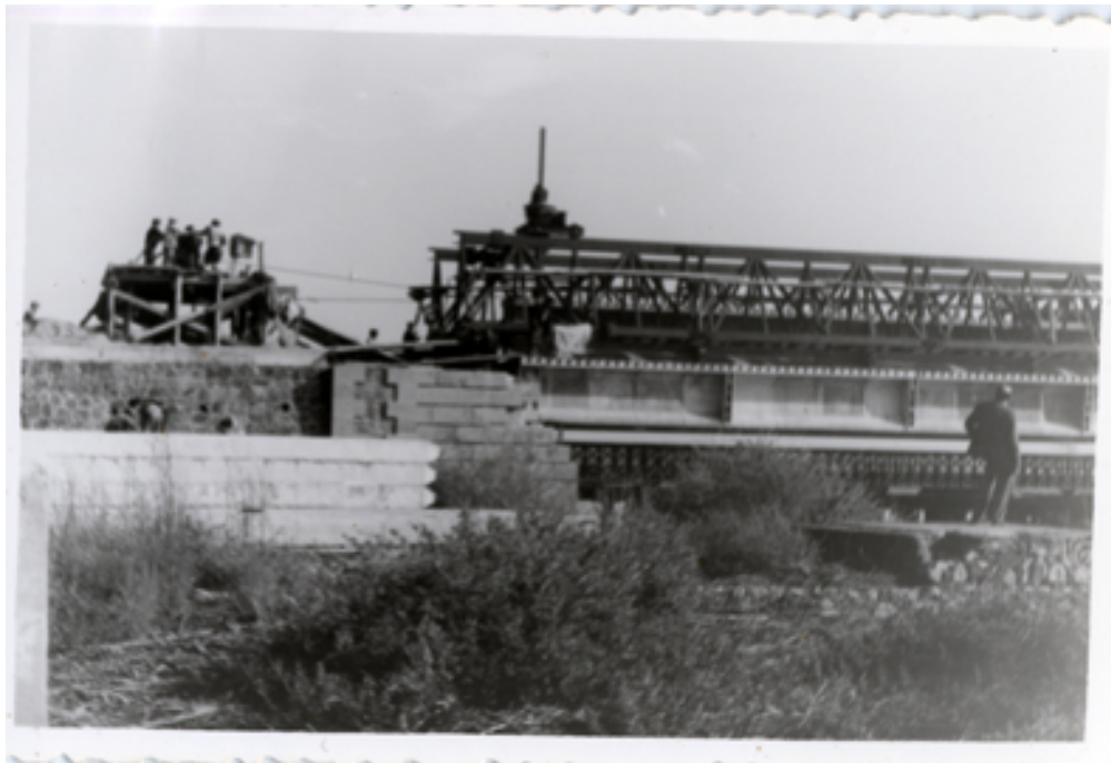
Vista del puente en construcción
