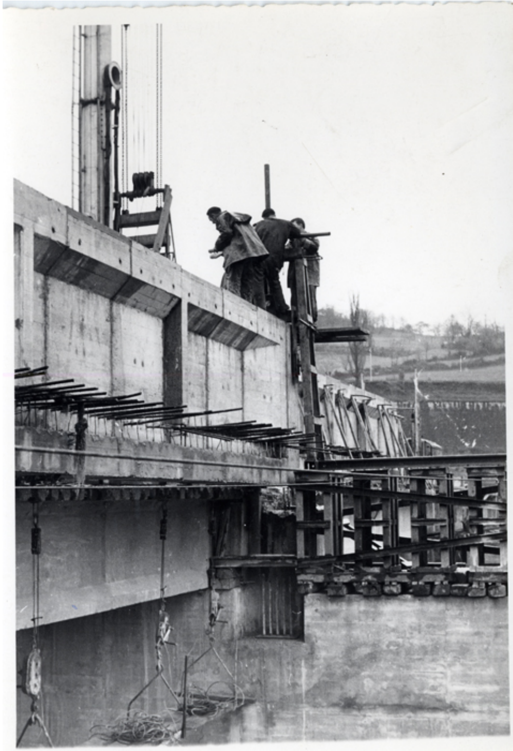
Detalle del puente en construcción
