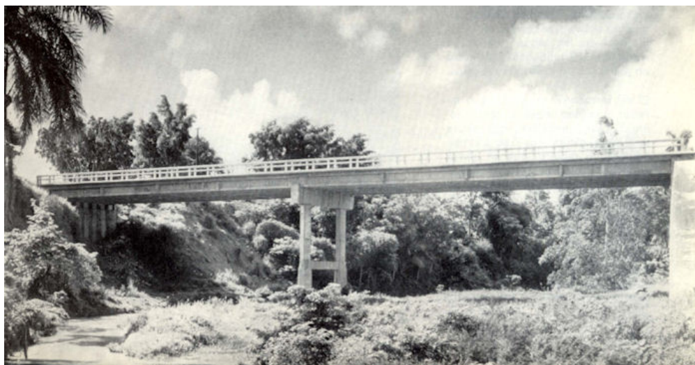
Vista del puente
