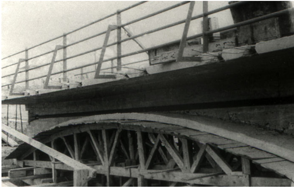
Detalle del paso
