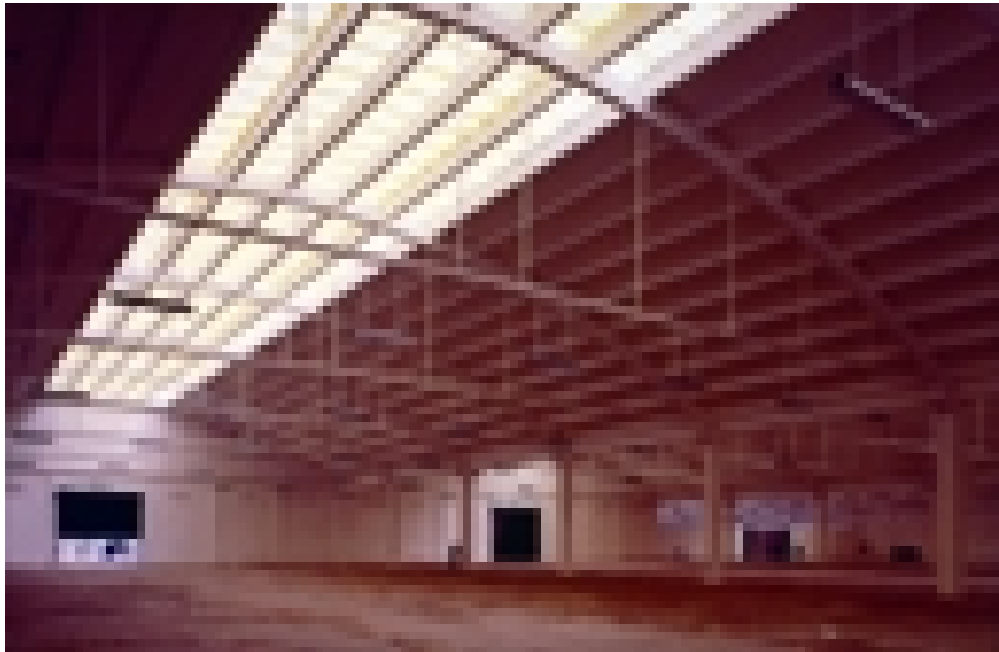
Vista del interior del edificio
