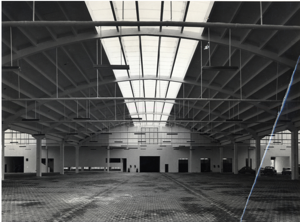
Vista del interior del edificio
