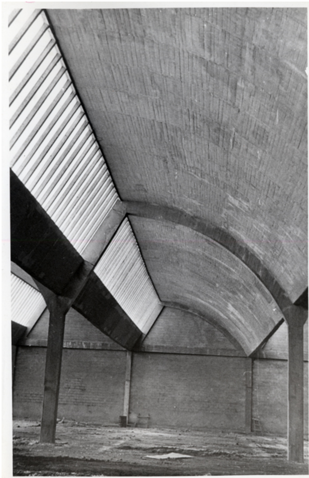
Detalle del interior de las naves
