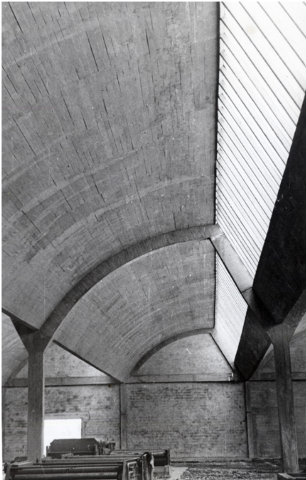
Detalle del interior de las naves
