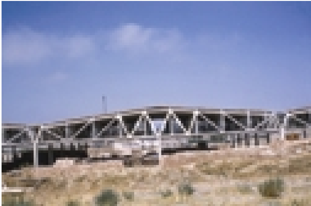
Vista de la nave en construcción
