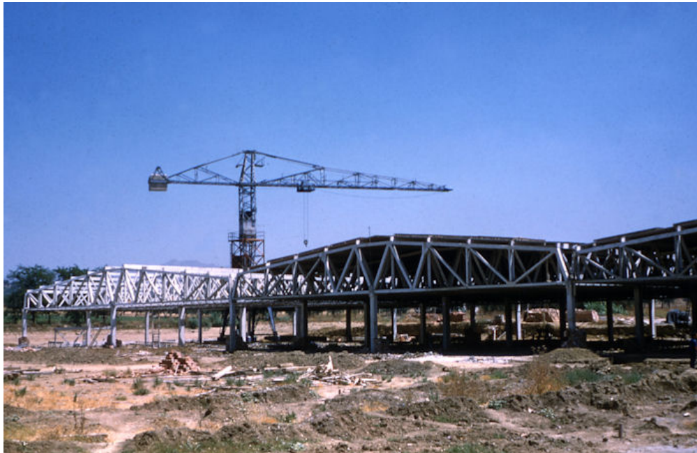
Vista de la nave en construcción
