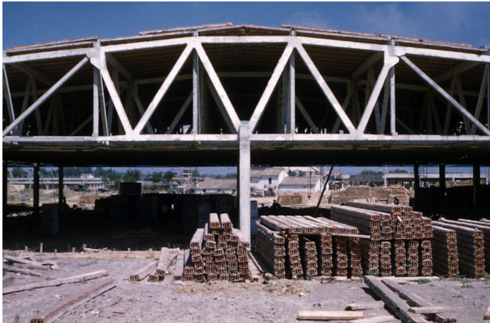
Vista de la nave en construcción
