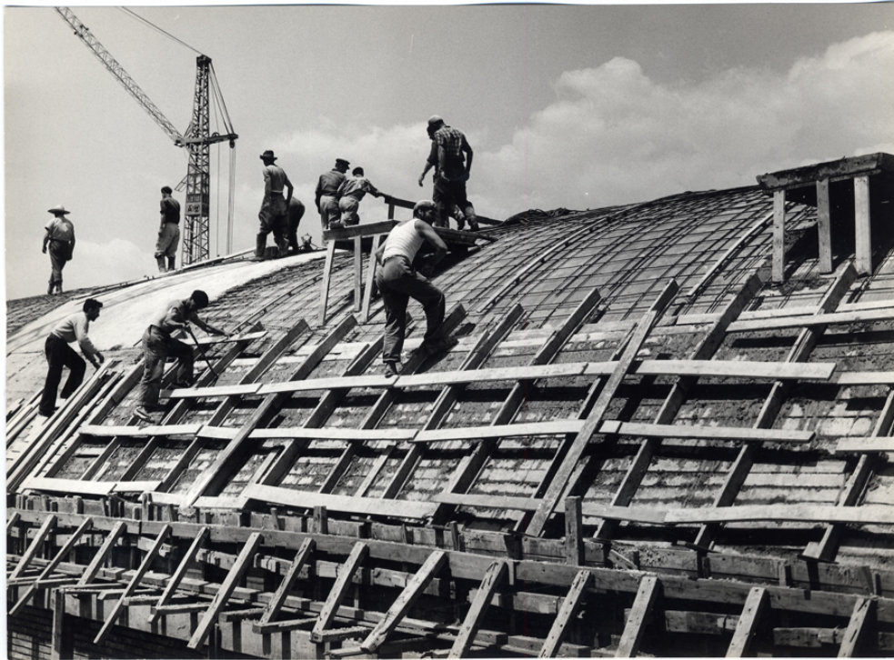
Detalle de construcción, obreros trabajando
