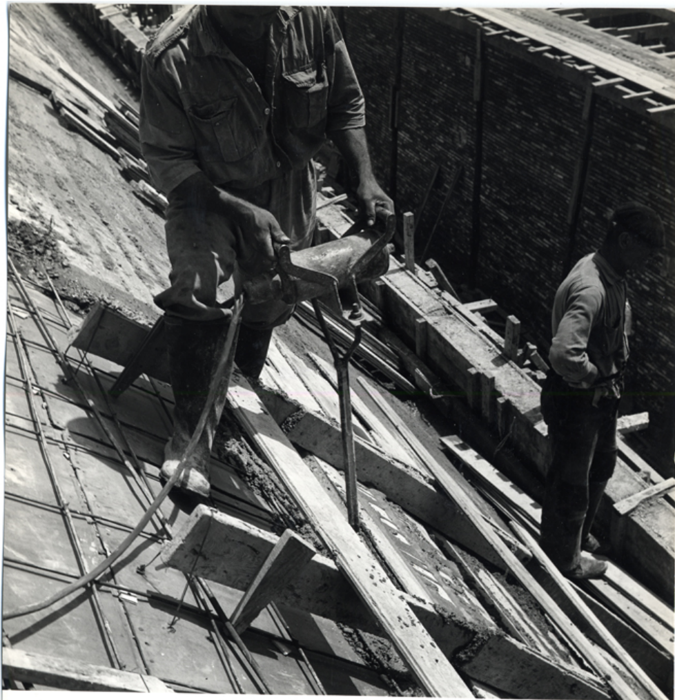
Detalle de construcción, obreros trabajando
