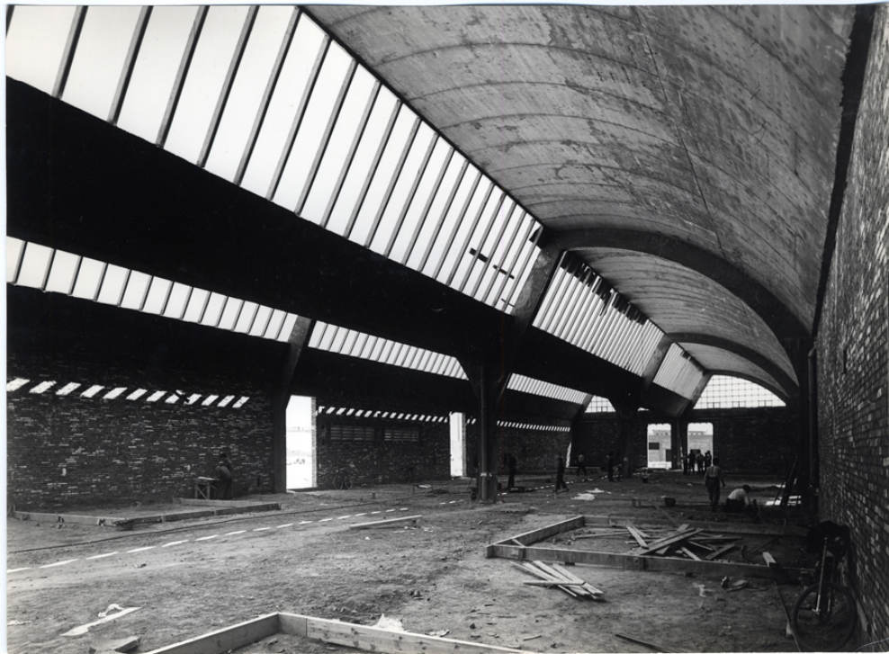
Vista del interior de la escuela en construcción
