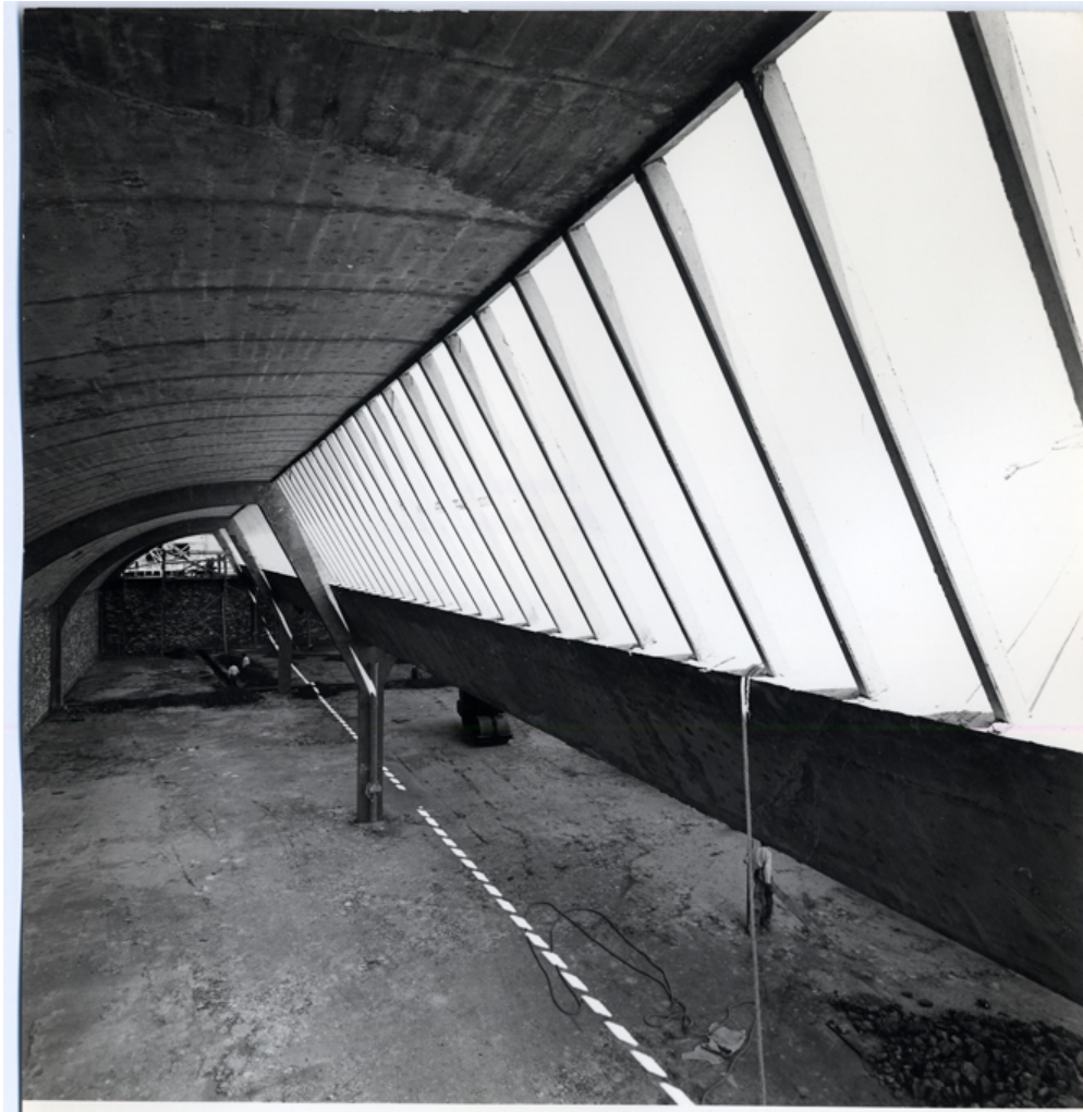
Detalle del interior de la escuela en construcción
