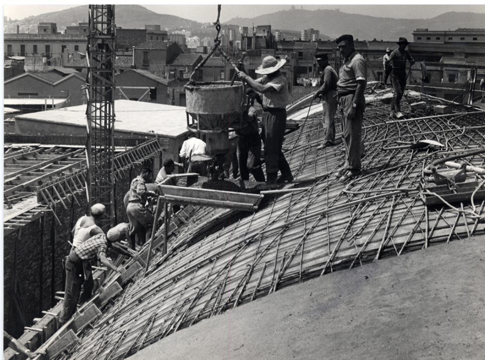
Detalle de construcción, obreros trabajando en el techado de la escuela
