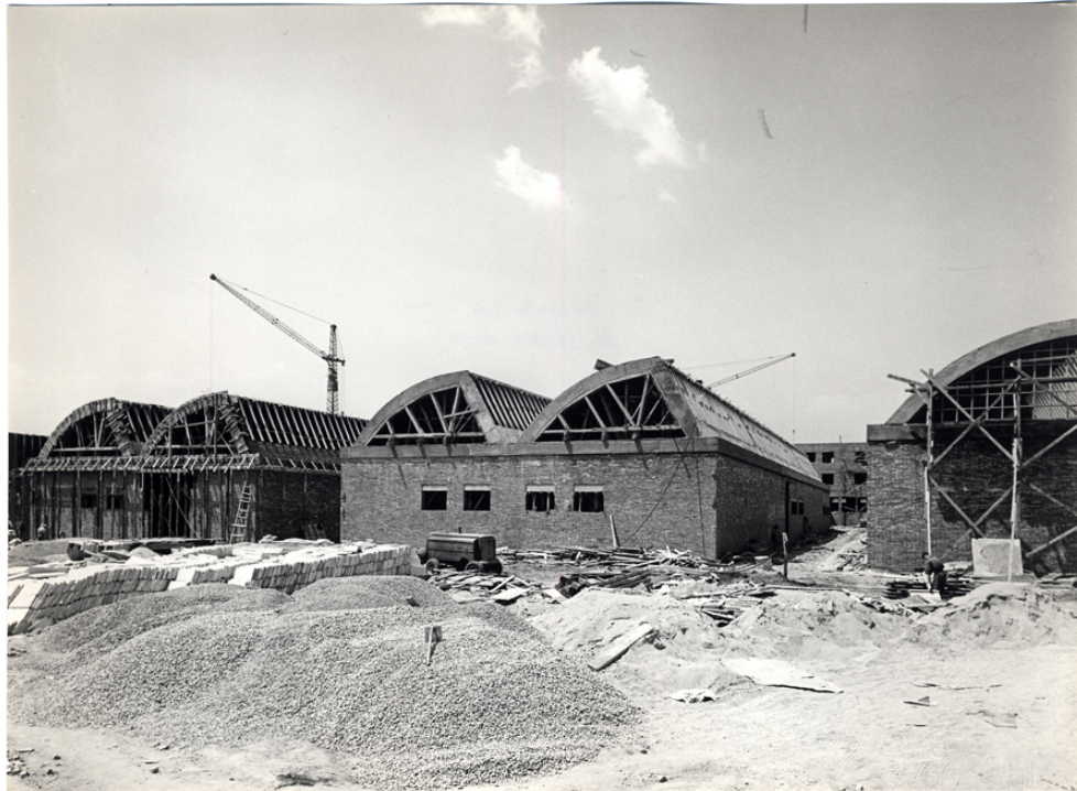
Vista de la escuela en construcción
