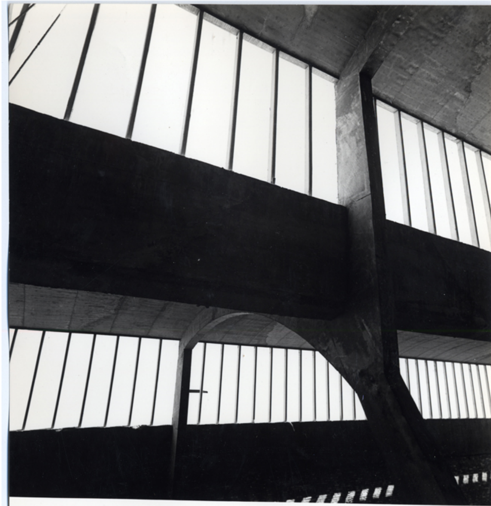
Detalle del interior de la escuela
