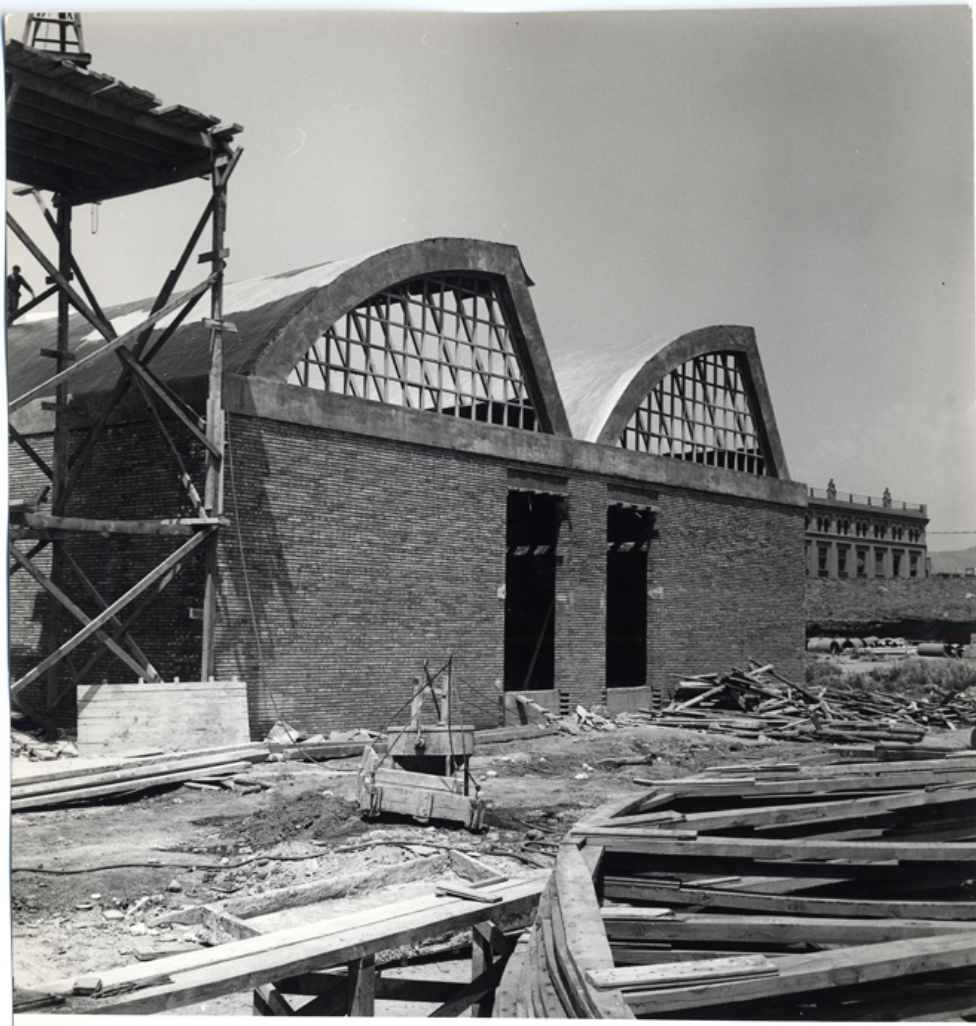
Vista de la escuela en construcción
