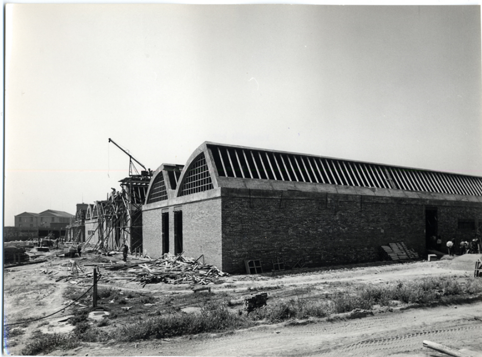
Vista de la escuela en construcción
